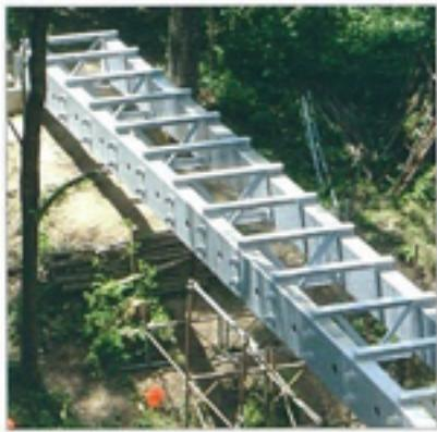
A sinistra, (apertura): fase di scarico delle travi di bordo, da 16 m, nella zona di posizionamento del ponte, ubicata a circa 500 m dal punto di deposito
